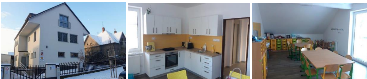
Obrázek 11 - Rekonstrukce hlavního objektu SVČ Slunečnice Přeštice - stav po rekonstrukci
