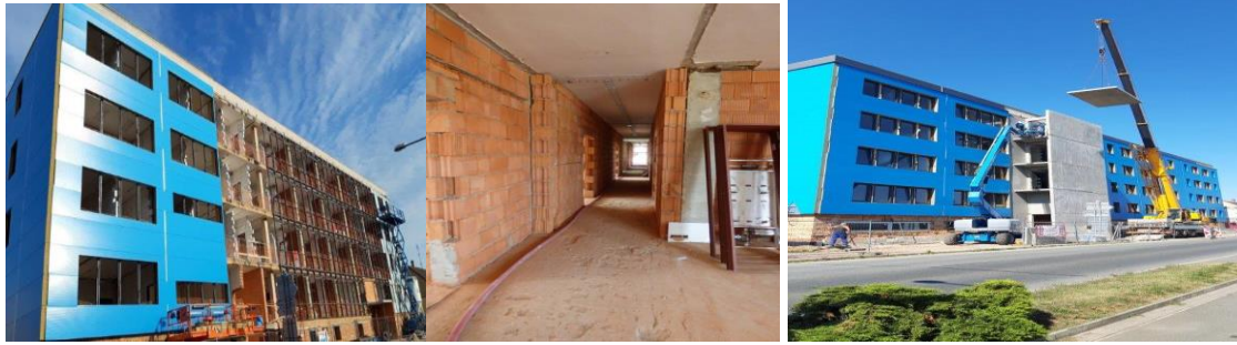
Obrázek 2 - Palackého č.p. 458, 460 - "Modrý dům - průběh rekonstrukce"
