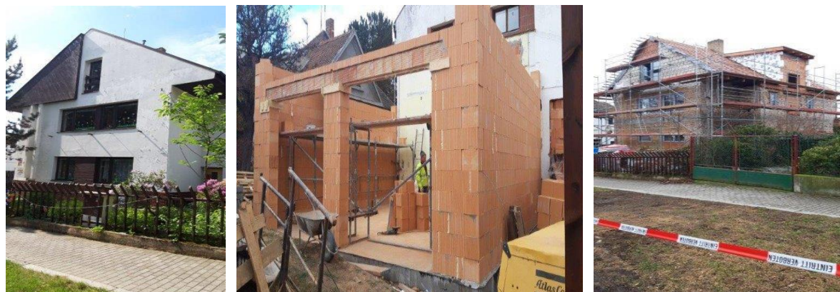
Obrázek 10 - Rekonstrukce hlavního objektu SVČ Slunečnice Přeštice - průběh rekonstrukce
