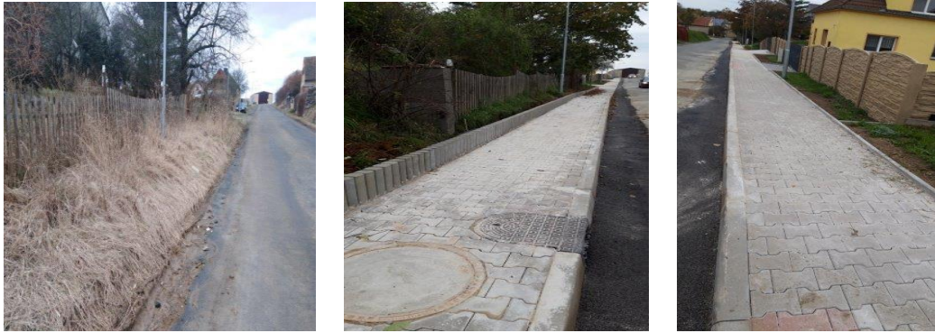
Obrázek 19 - Vybudování nového chodníku ve Skočicích II. část k Roupovu
