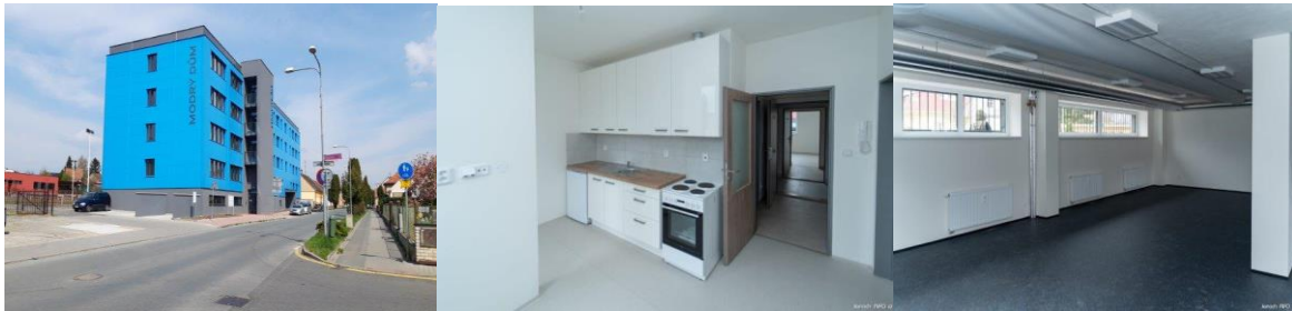
Obrázek 3 - Palackého č.p. 458, 460 - "Modrý dům - ukončení rekonstrukce"
