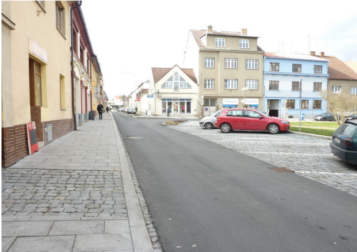
Ulice Komenského po rekonstrukci
