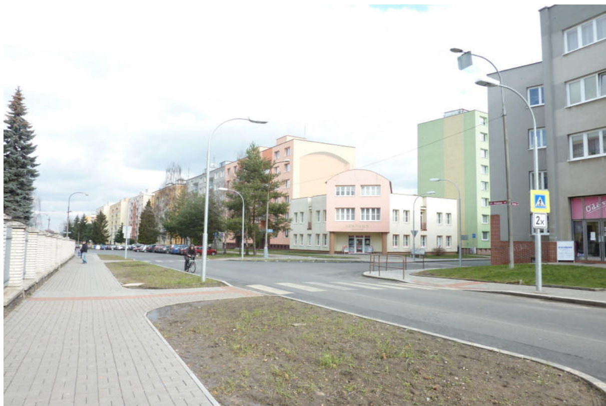
Přechod pro chodce v Husově ulici
