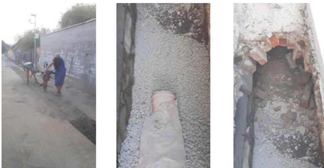
Obrázek 6 – Kanalizační přípojka - Hlávková č.p. 22 – realizace
