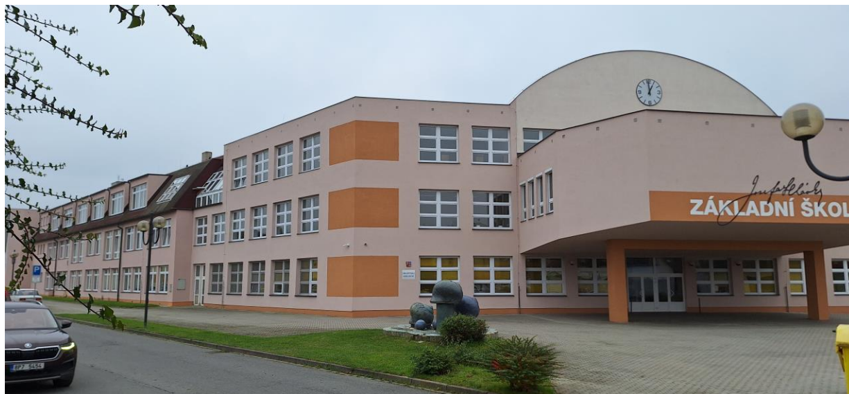
Obrazek 19 – 2. etapa opravy fasády budovy ZŠ Josefa Hlávky Přeštice
