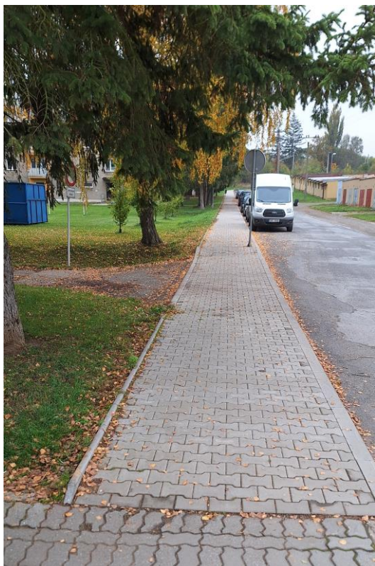
Obrázek 18 – Oprava chodníku v Dukelské ul. V Přešticích
