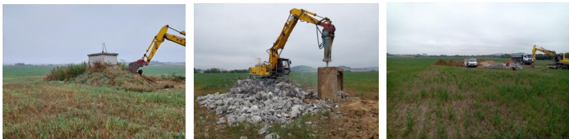
Obrázek 9 – Likvidace nadzemní části vrtu P3
