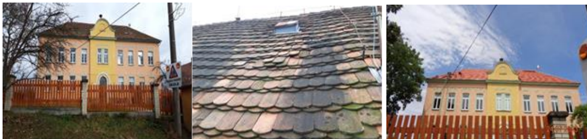
Obrázek 7 - Výměna střešní krytiny na budově ZŠ a MŠ Skočice
