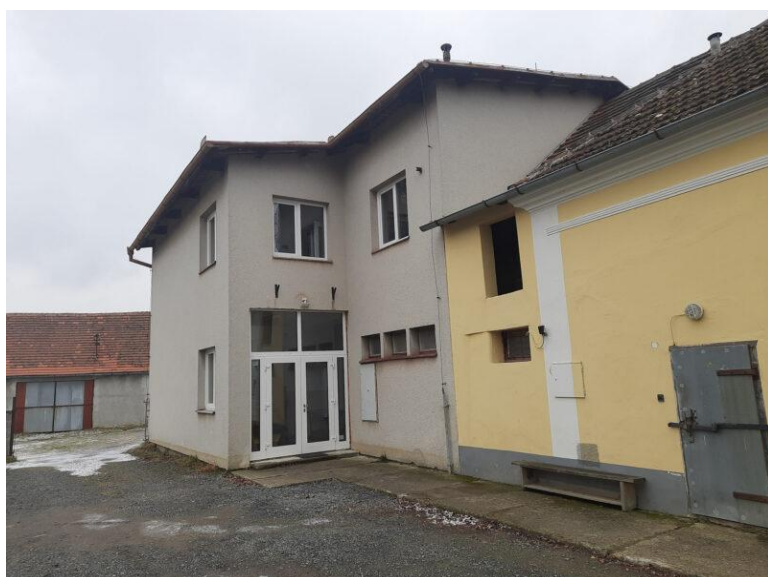
Obrázek 4 - Budova č.p. 41 Žerovice
