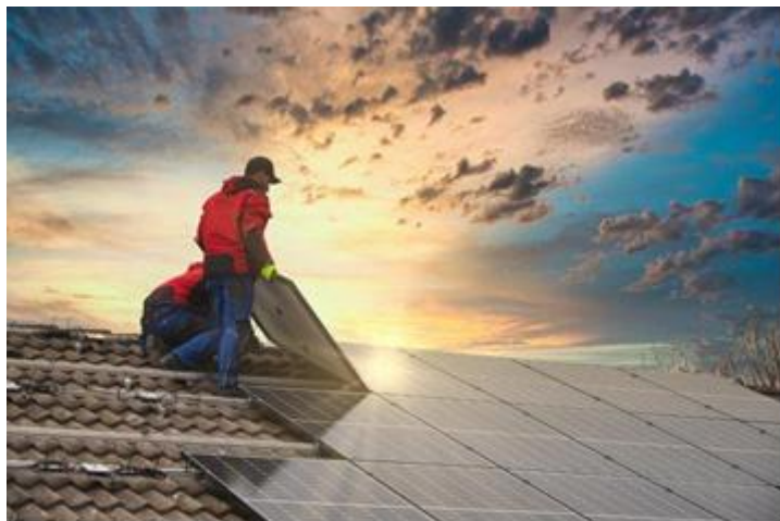
Obrázek 10 – Realizace FVE na objektu ČOV
