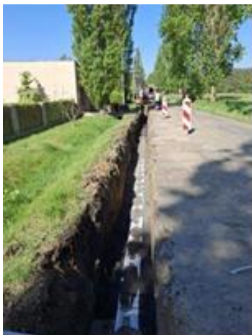
Obrázek 9 – Prodloužení stávajícího vodovodu Zastávka
