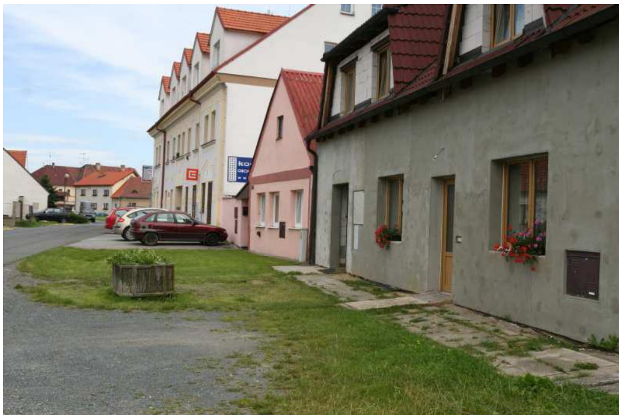
Obr. II.6.: Objekt občanské vybavenosti a RD poblíž Havlíčkova náměstí.
