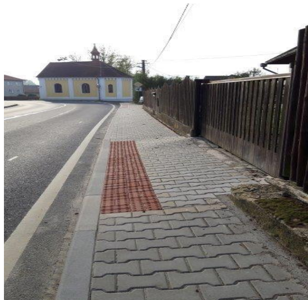
Obrázek 20 - Oprava chodníku Skočice po realizaci 2
