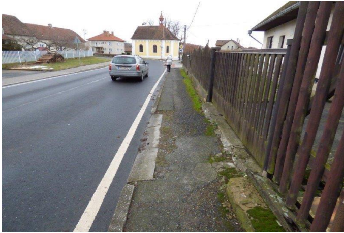
Obrázek 19 - Oprava chodníku Skočice před realizací 2
