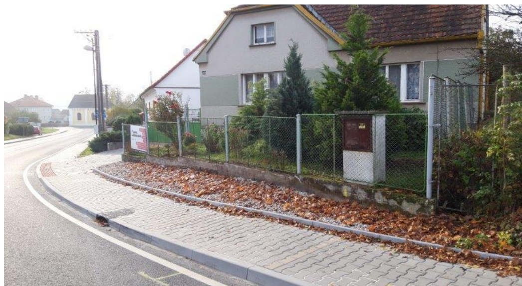
Obrázek 18 - Oprava chodníku Skočice po realizaci 1
