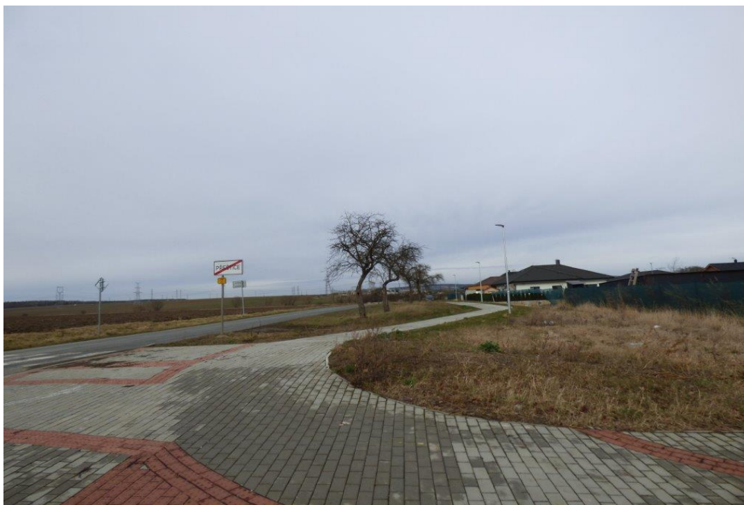
Obrázek 6 - Výstavba chodníku Dolnolukavická v Přešticích - pohled 1
