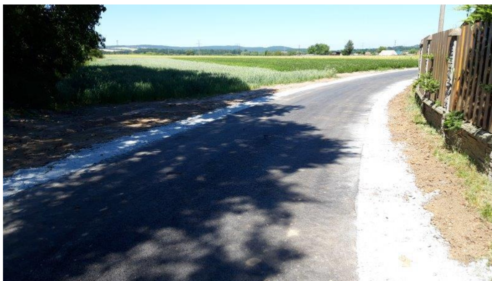
Obrázek 13 - Oprava komunikace v Háječku
