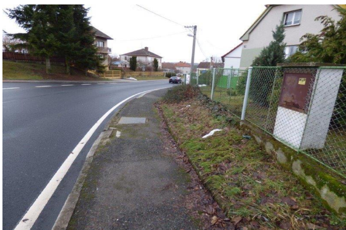
Obrázek 17 - Oprava chodníku Skočice před realizací 1
