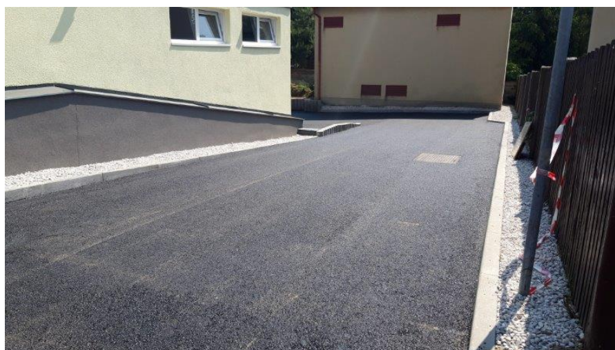
Obrázek 14 - Zpevněný povrch - garáže pro sanitní vozy
